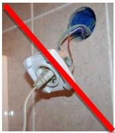
а) эксплуатировать электропровода и кабели с видимыми нарушениями изоляции;
