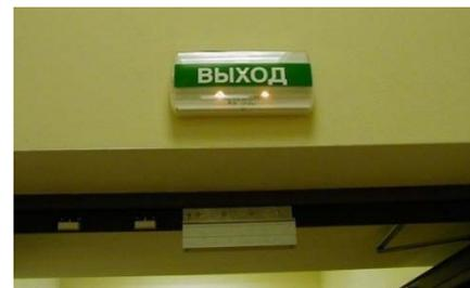
Эвакуационное освещение должно включаться автоматически при прекращении электропитания рабочего освещения.
